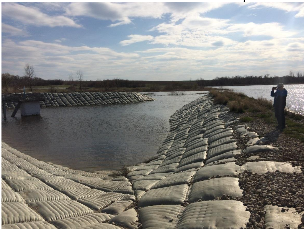
Рисунок 1 – Облицовка подводящего канала водосбросного сооружения Михайло-Овсяновского водохранилища
